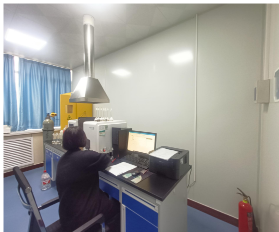
实验室分析仪器上方集气罩
